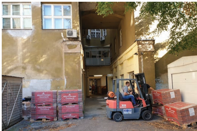
Popotresna obnova stavbe Slovenskega doma Zagreb, april in maj 2020. Vse foto: dš
