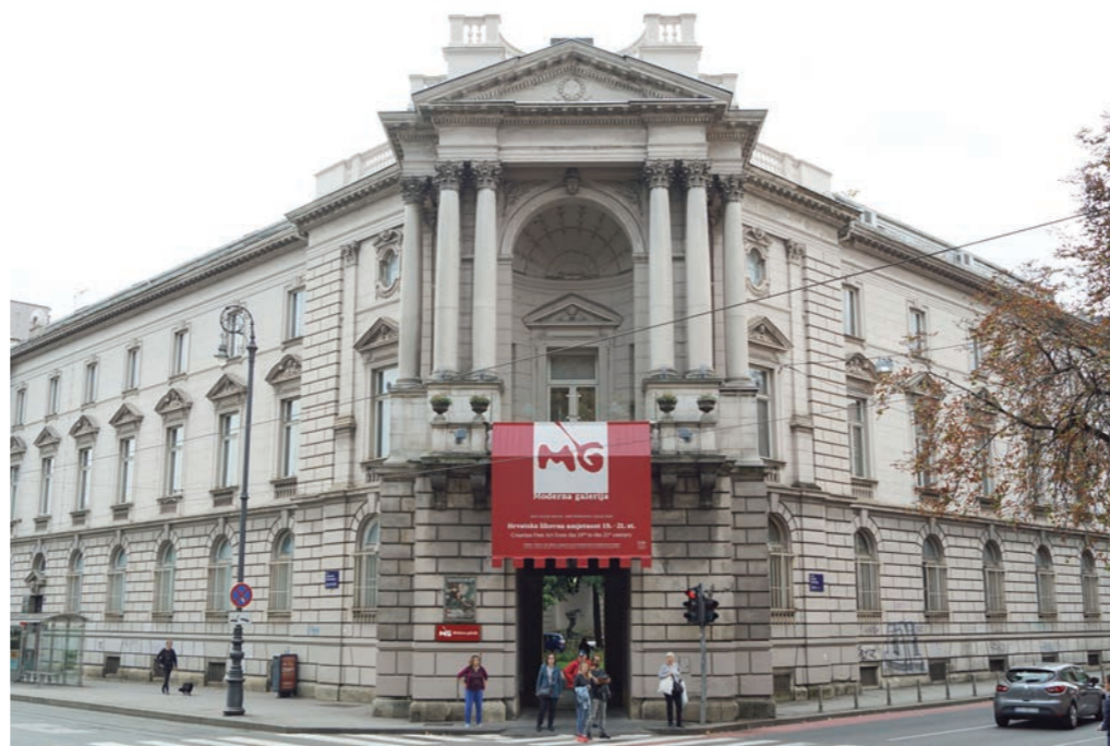
Moderna galerija, pročelje Foto: A. Bukovec
