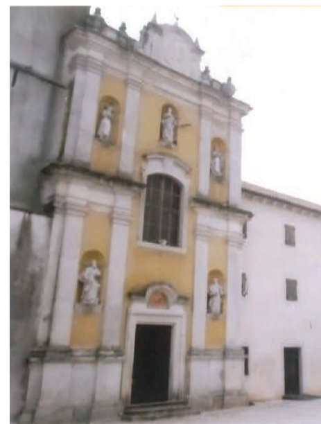
Crkva i samostan, danas Cerkev in samostan danes
