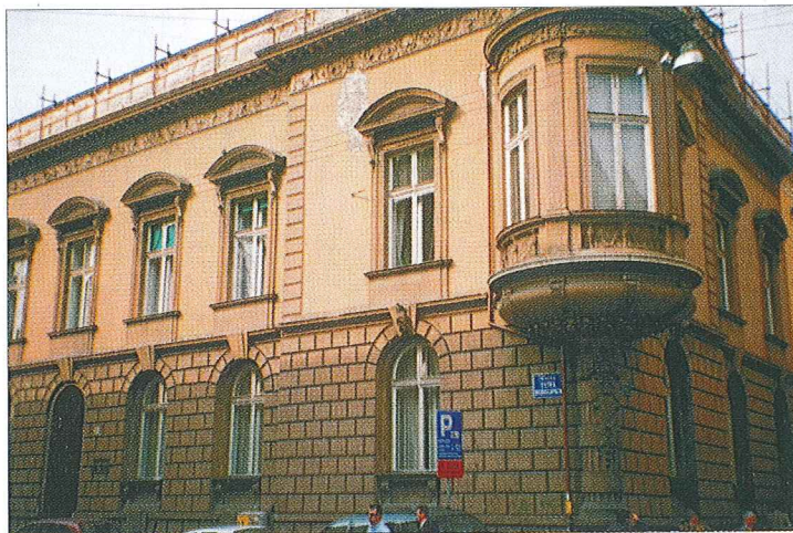
Stavba na Berislavičevi ulici 6, kjer je bil takoj po 2. svetovni vojni leta 1945 nekaj mesecev sedež Slovenskega doma.
