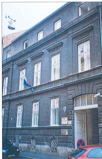
Stavba na Berislavićevi ulici 11, kjer je bil v letih 1938-40 sedež Narodnega doma.
