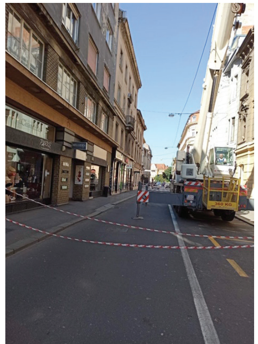
Vhod v Slovenski dom, 25. maj 2020. Obnova še poteka. Obe foto: Jasminka Bednjanec
